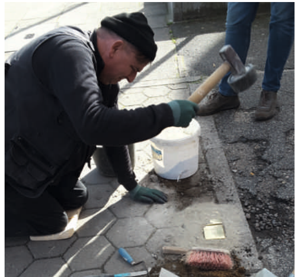
Handwerker, die die Messing-Quader fachgerecht im Bürgersteig versenken.
