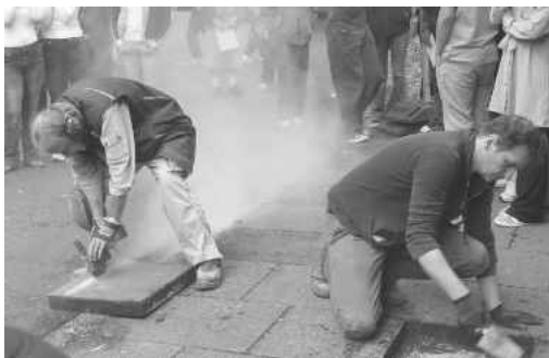
Gunter Demnig (I) sägt die Gehsteigplatte für die Stolpersteinverlegung zurecht.
